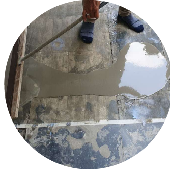
2 - RESURFACING COAT การปรับพื้นผิว
